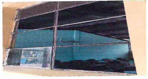
Foto 6: sustitución de estructura de metal de ventana
