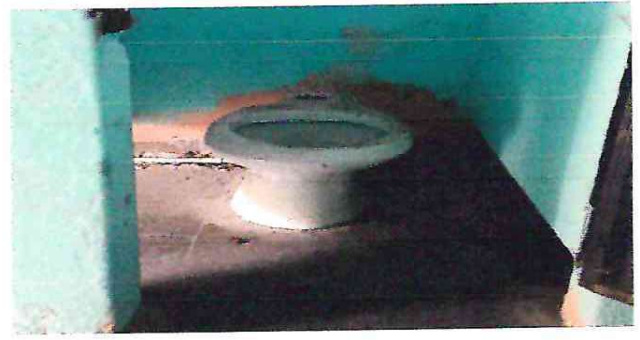
Foto 4: sustitución de inodoro
