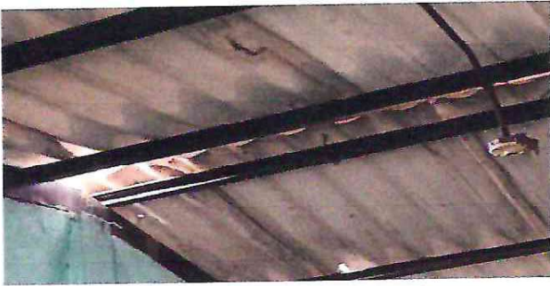
Foto 1: sustitución de lamina por lamina troquelada
