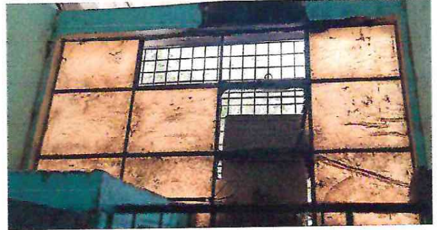
Foto 2: sustitución de ventanas
