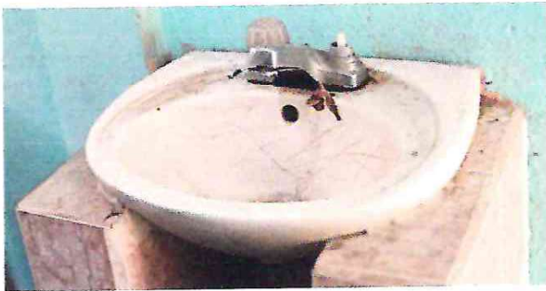
Foto 3: sustitución de lavamanos
